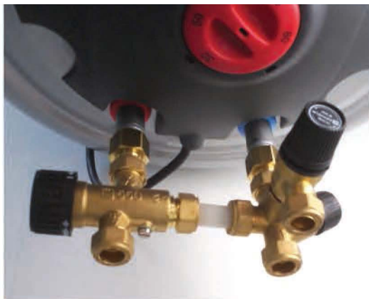
LK Armatur varolaiteryhmä termostaattisella sekoitusventtiilillä
